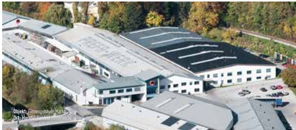
Objekt: Firmengebäude Wasungen Ort: Wasungen (Deutschland)
