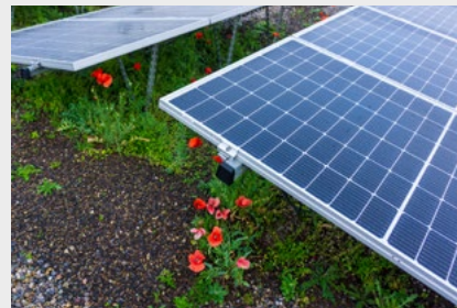
Solarmodule mit Klemmen einfach montiert.
