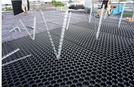
Einfache Montage der V-Träger auf Bodenschiene: einklicken, verschrauben.
