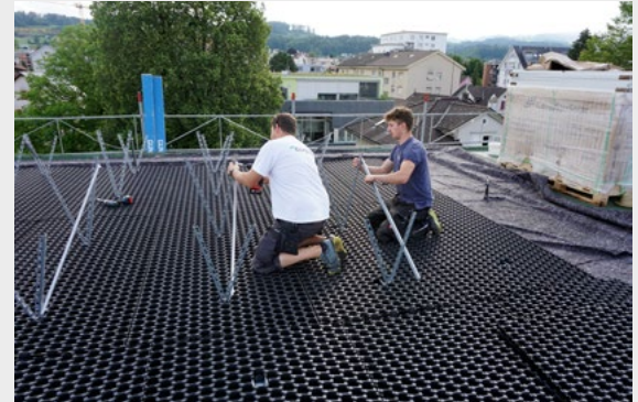
Diagonalprofile montieren.
