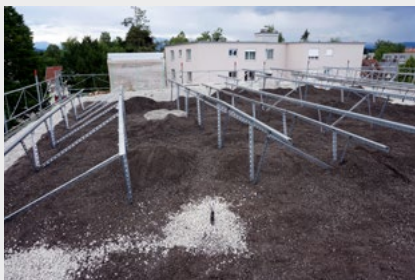
Fertig montierte PV-Unterkonstruktion mit Substrat als Ballast.
