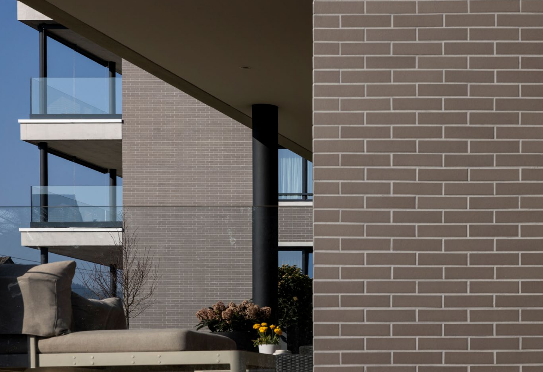
Überbauung «Neu See Land» in Rorschacherberg: Unglasierter Klinker in dezemtem Steingrau macht die Fassade ruhig.
