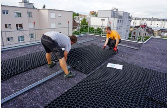
Bodenschienen und Grundplatten werden gemäss Plan verlegt.
