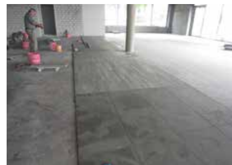
Enger Zeitplan: Für den Einbau des Unterlagsbodens und die Plattenarbeiten standen nur rund sechs Wochen zur Verfügung.
