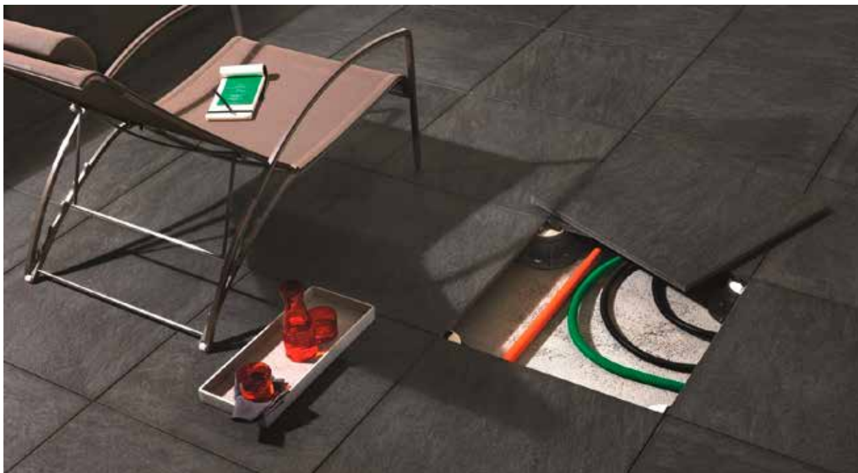
Einfache Verlegung von Kabeln und Rohren
