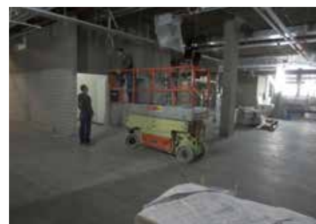
Nach kurzer Zeit war eine rasche Belastung sowohl des Unterlagsbodens als auch des fertig verklebten Plattenbelags notwendig.
