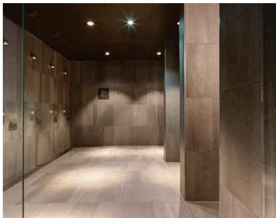
Keramische Feinsteinzeugplatten an Wänden und Böden.
