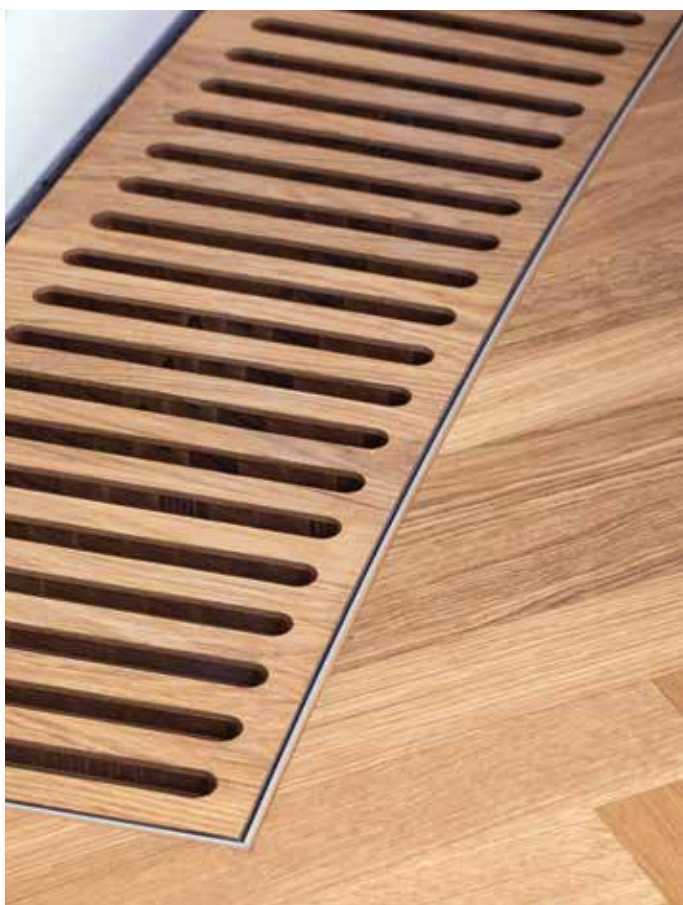
Das saubere Anschneiden des Parketts an die Heizkanäle erfordert ein überaus exaktes Arbeiten.
