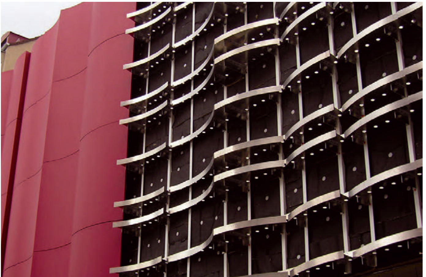
Unterkonstruktion Brechtbühne, Augsburg
