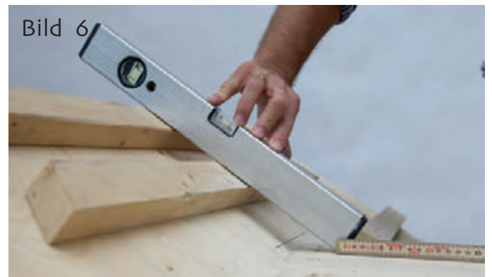
Bild 6 Dabei beachten, dass vom Ortgang bis zum Schnittpunkt der Oberkante Dachlattung gemessen wird.
