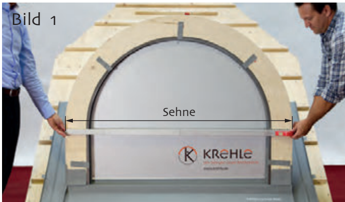
Bild 1 Gaubenbreite (Sehne) bis zur Außenkante der Schalung messen (zuzüglich Strukturmatte).
