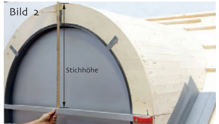
Bild 2 Stichhöhe von der Gaubenmitte bis zur Oberkante Schalung messen (zuzüglich Strukturmatte).
