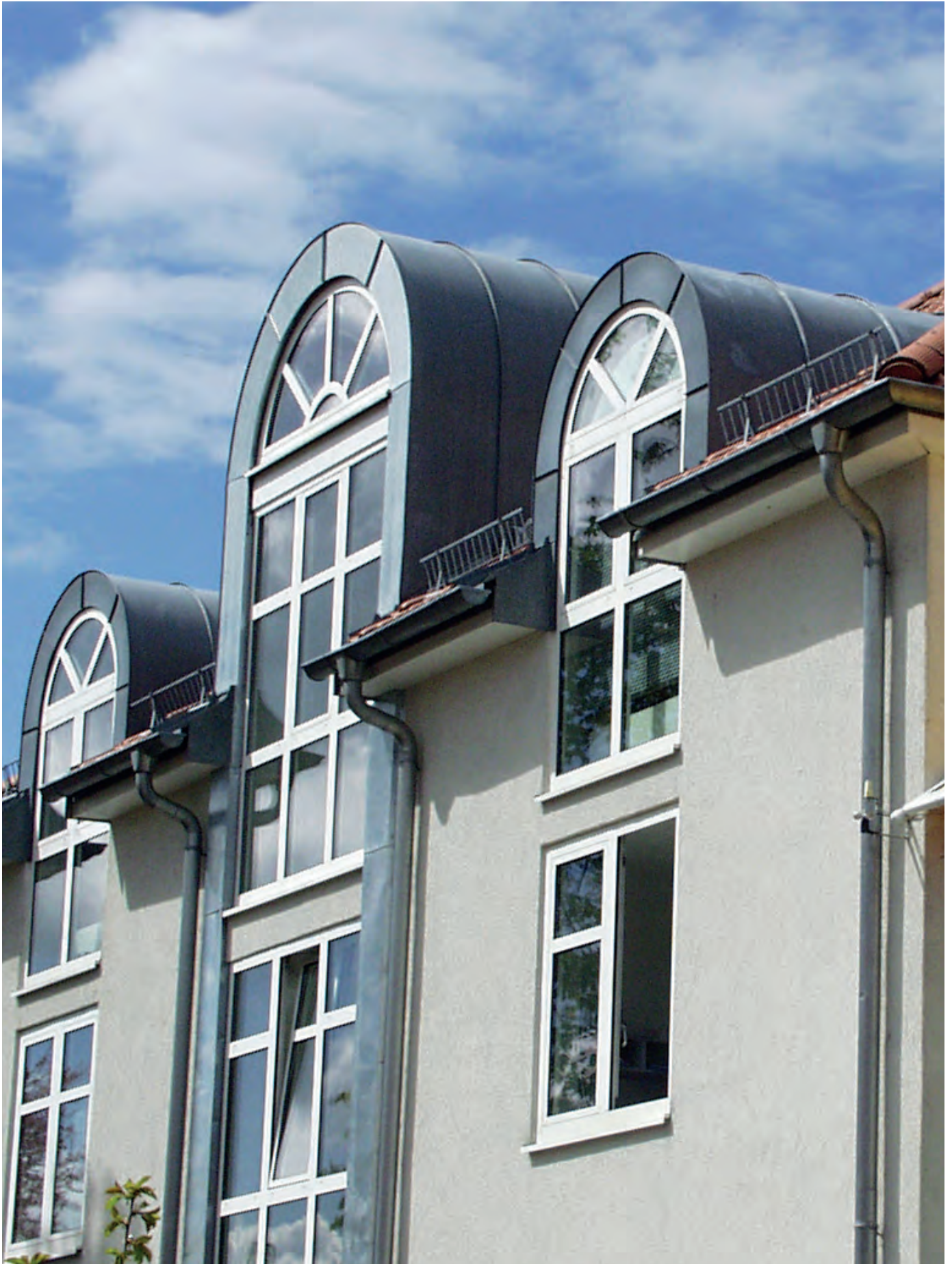
Wohn- und Geschäftshaus, Herrsching am Ammersee
