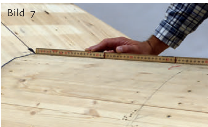
Bild 7 Firstlänge messen bei Metalldeckung: Vom Ortgang bis zum Kehlnick.
