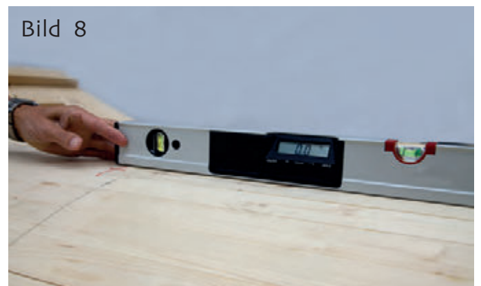
Bild 8 Prüfen ob der First waagrecht ist. (Abweichungen im Formblatt vermerken).
