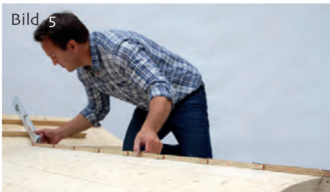
Bild 5 Firstlänge messen bei Ziegeldeckung: Vom Ortgang bis Oberkante Dachlattung.
