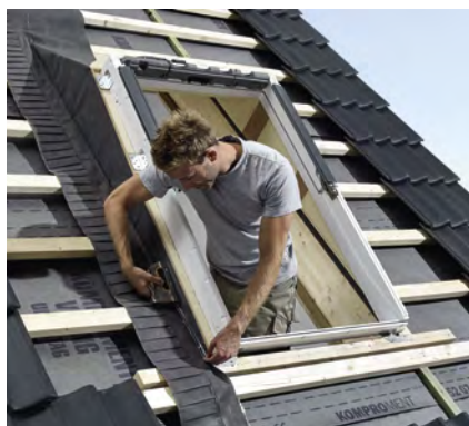
4. Für den regensicheren Anschluss die mitgelieferte Unterdachschürze BFX montieren.
