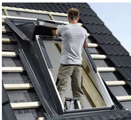
5. Anschließend die Aussenverblechung anbringen und den Fensterflügel einsetzen.
