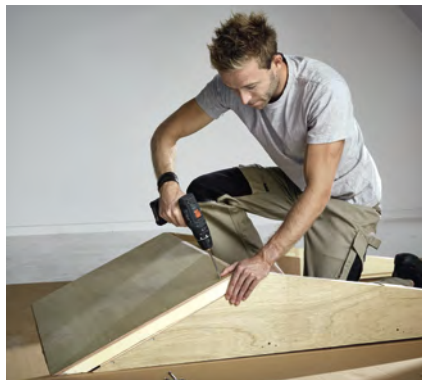
1. Die im Lieferumfang enthaltenen Dämmteile montieren.
