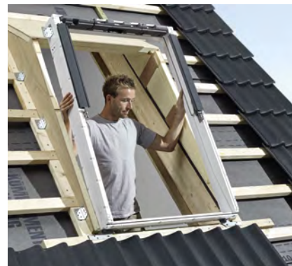
3. Fenster-Blendrahmen in die Dämmung einsetzen und verschrauben.
